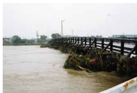
梅雨前線豪雨時の状況
