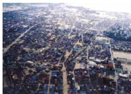
梅雨前線豪雨時の状況
